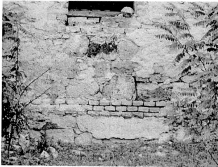
Az időjárásnak fokozottan kitett külső felületen a homlokzati vakolat sérült, lepergett, ott már a téglá szerkezeteken is megjelentek az időjárásból eredő károsodások.
