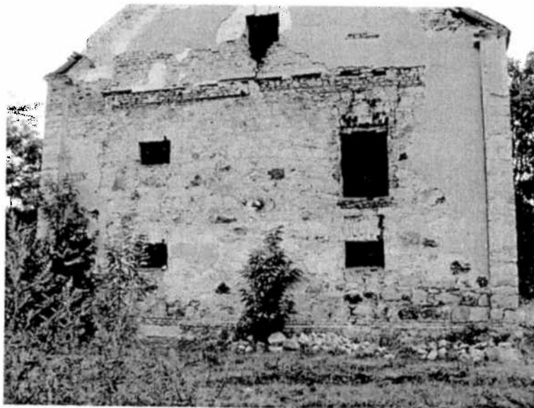
Az időjárásnak fokozottan kitett külső felületen a homlokzati vakolat sérült, lepergett, ott már a téglá szerkezeteken is megjelentek az időjárásból eredő károsodások.
