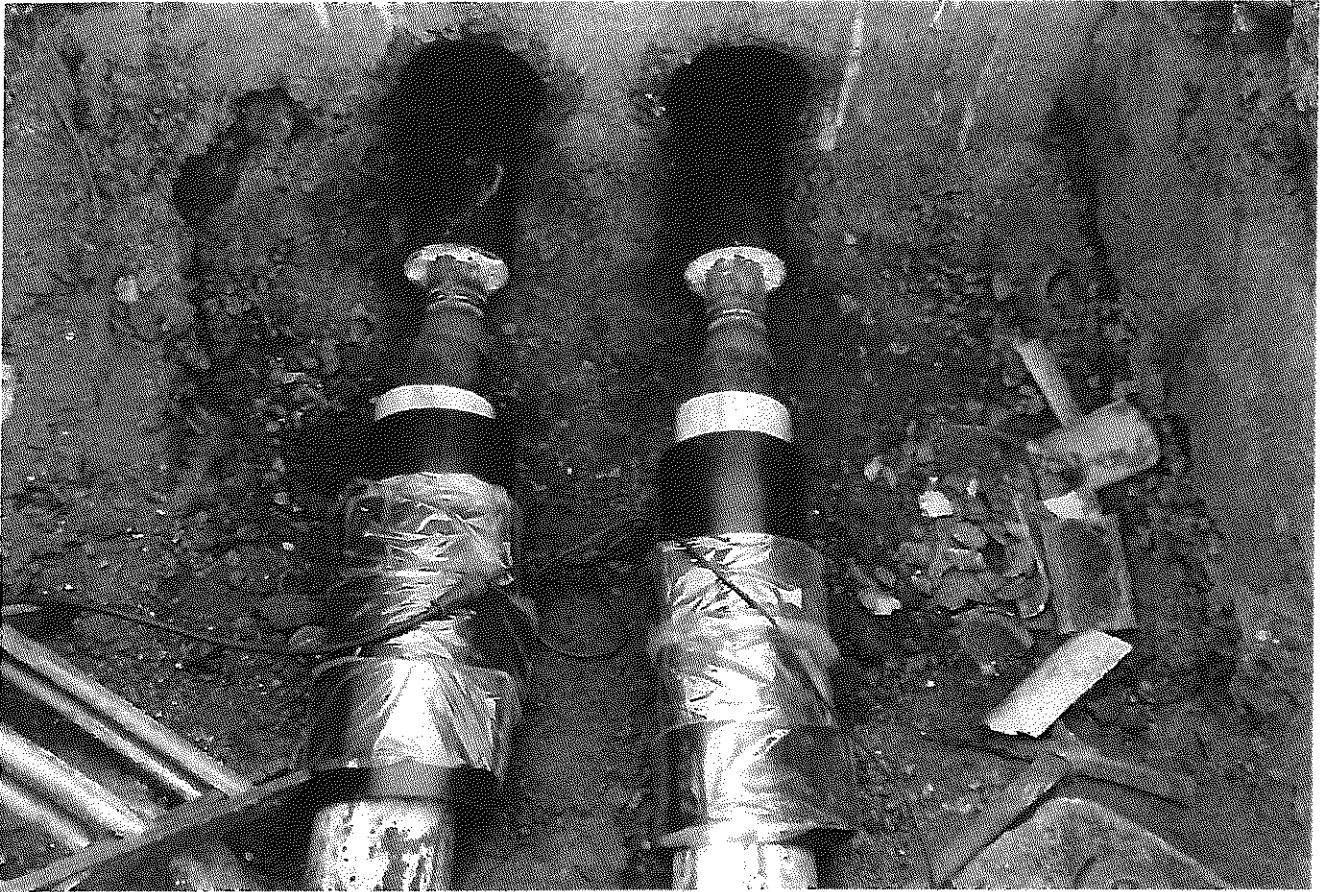
Beépített szakasz nyomáspróba alatt, lezárás előtt
