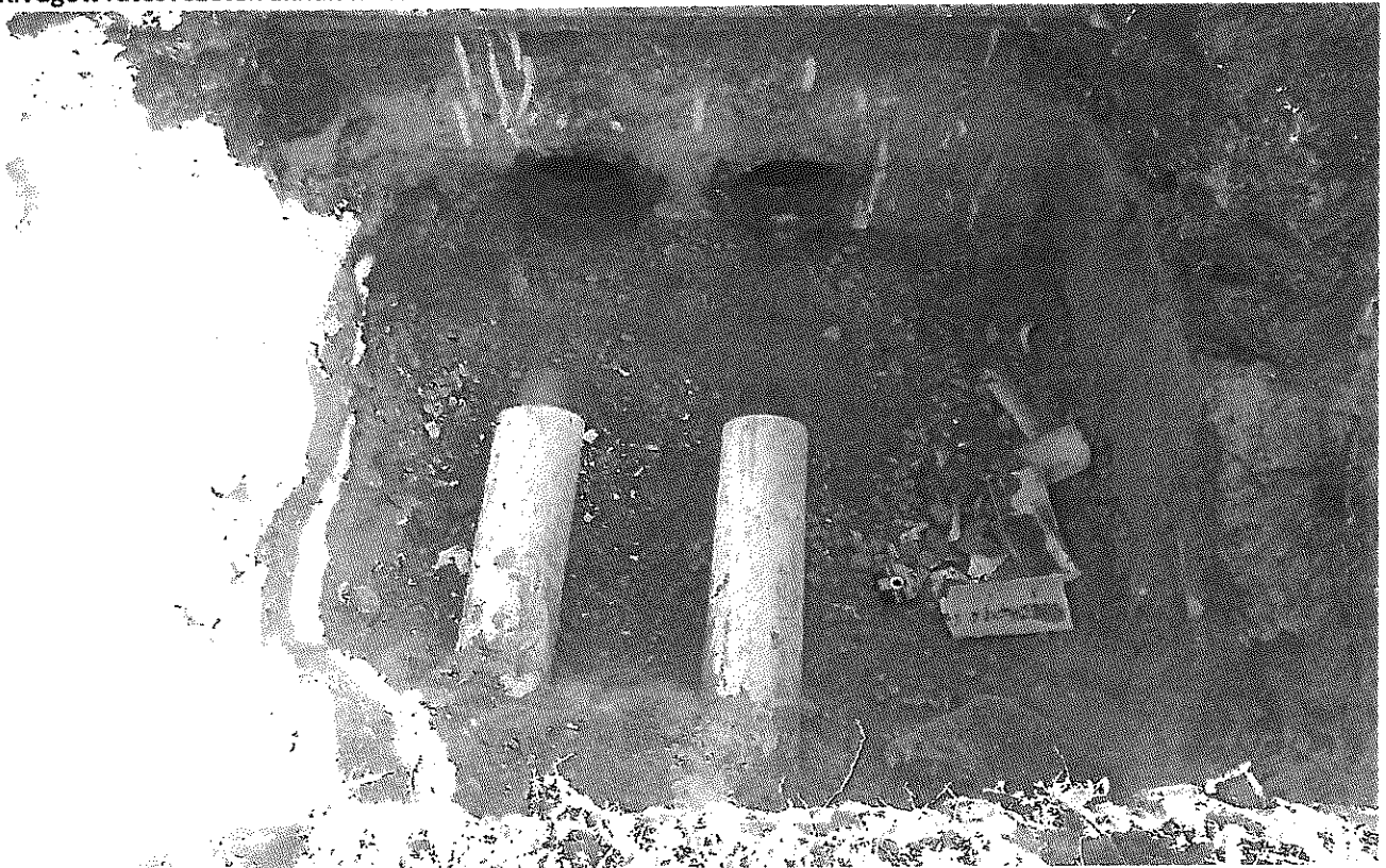
Kivágott fűtésvezeték aknán kívüli szakasz
