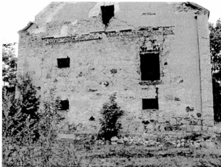
Az időjárásnak fokozottan kitett külső felületen a homlokzati vakolat sérült, lepergett, ott már a téglá szerkezeteken is megjelentek az időjárásból eredő károsodások.
