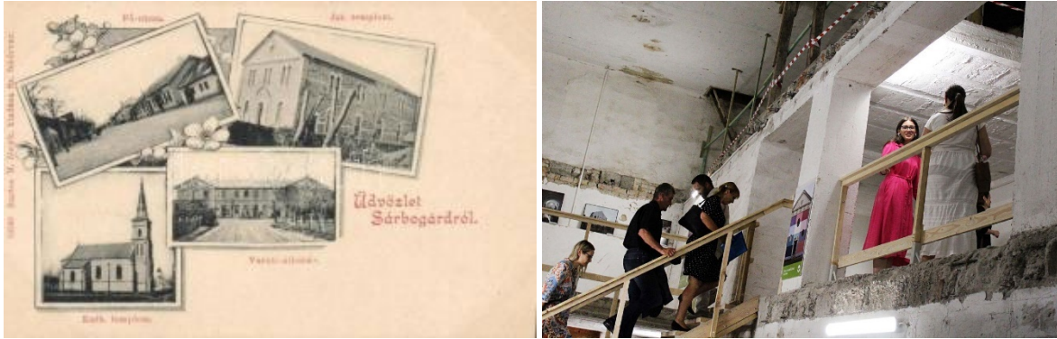
régi képeslap és a mára lebontott beton belső rész
